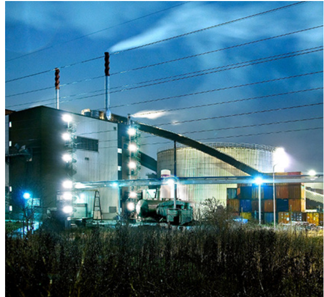
Vattenfalls anläggning i Uppsala består av flera olika enheter som producerar el, fjärrvärme, fjärrkyla och ånga.
