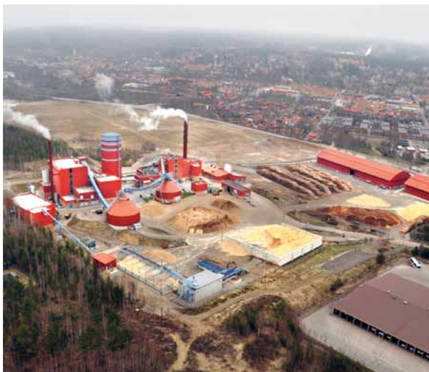
Falu Energi & Vatten är ett bioenergikombinat med kraftvärme och pelletsproduktion.
